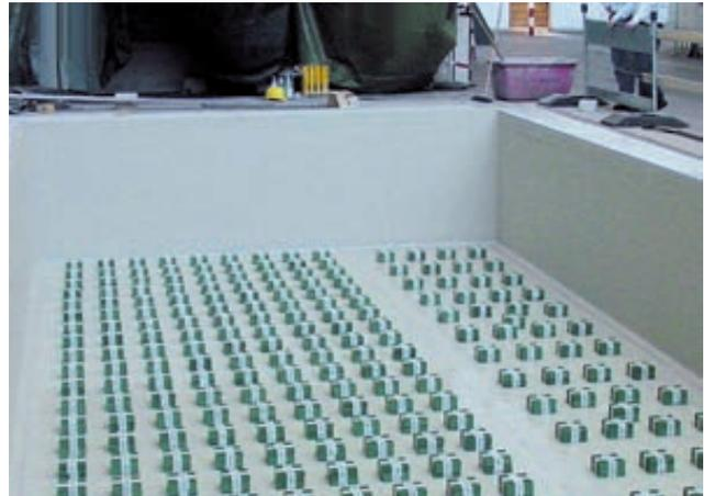
Cuve de fondation équipée des kits de plaques d'isolation Bilz
