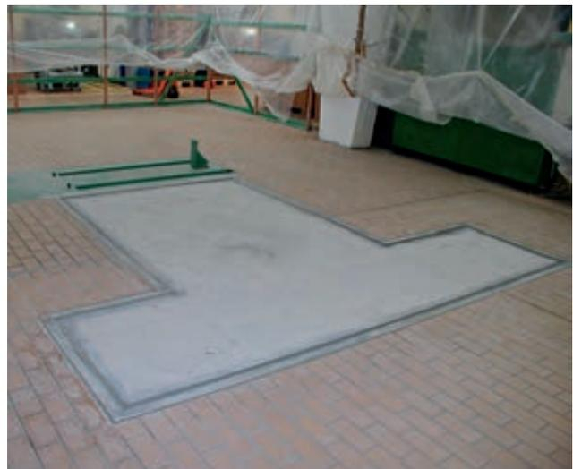
Bloc béton avec coffrage métallique
