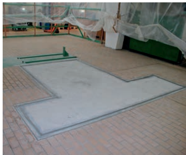
Bloc béton avec coffrage métallique
